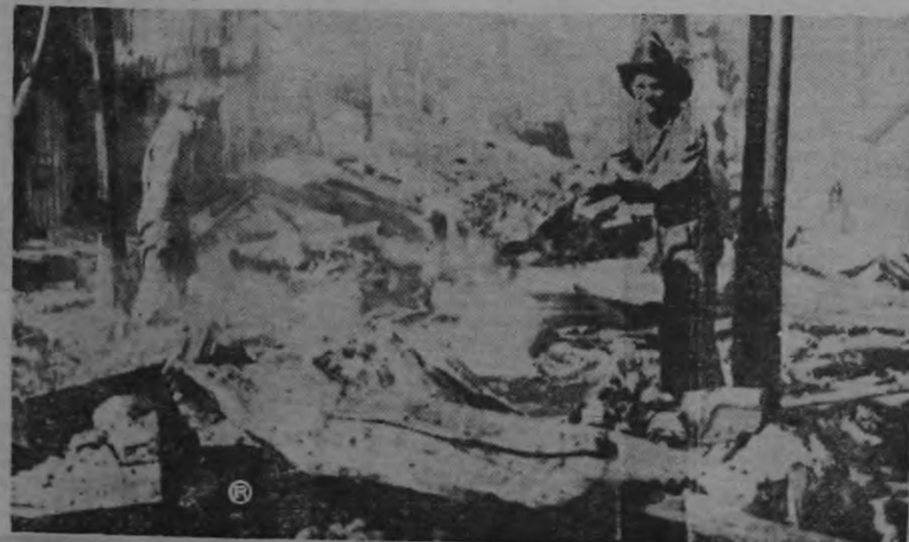
Así quedó la parte posterior de la Colchonería Luxor. Maquinaria, materia prima e instalaciones fueron destruidas por las llamas. Los bomberos lucharon denodadamente, pero la falta de aguahizo que no se pudiera evitar la total destrucción. (Foto Meza)
