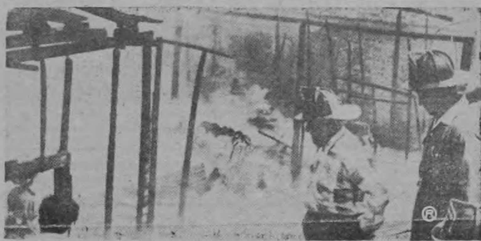
En la gráfica, el Comandante del Cuerpo de Bomberos y Gerente del Instituto de Seguros don Jorge Escalante en el techo del bar La Sevillana. Como todos sus compañeros corrió los mismos riesgos en la difícil y peligrosa labor de controlar las llamas.
